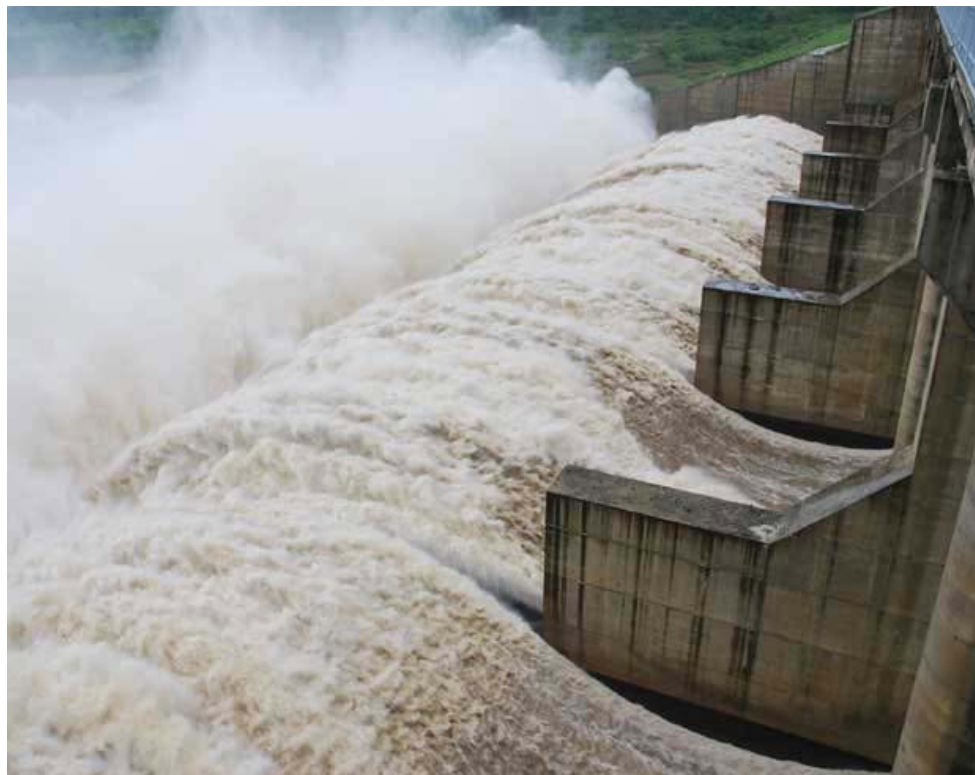
Hình 16. Đập thủy điện
